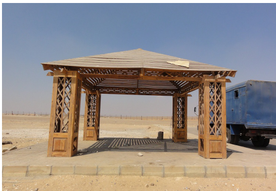
Fig.2 屈折ピラミッド北西側にある 駐車場に隣接する東屋 2011年8月19日
